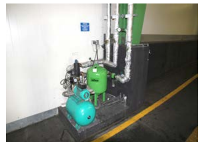
Regenwassereinspeisung
